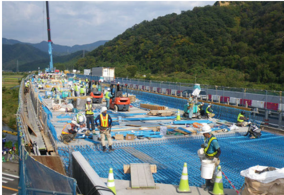
床版取替本線作業
