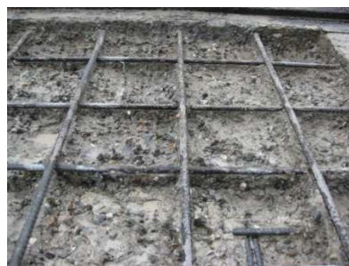
床版劣化部撤去箇所
