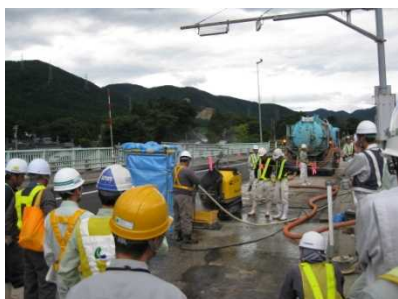
ウォータージェット施工状況
