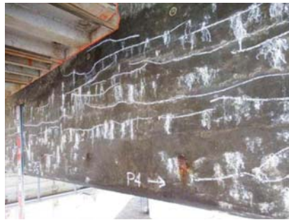
写真 側道橋のASRの事例(1986年(昭和59年)供用)
