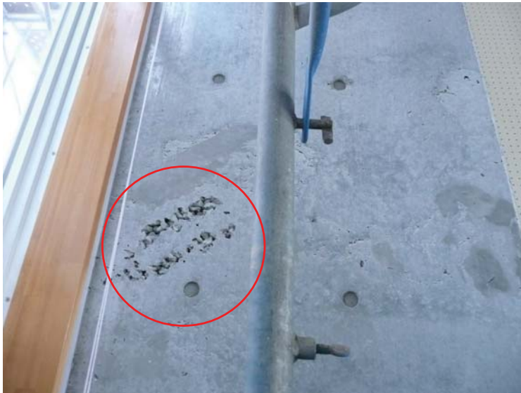
写真 鉄筋コンクリートの柱に発生したジャンカ
