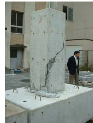
写真 せん断破壊した柱
