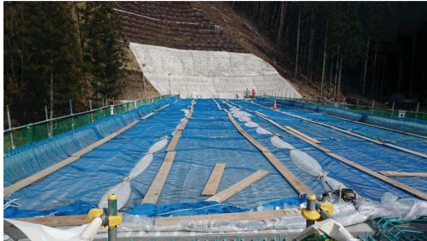
3ヶ月の長期養生。保水シート+2層のプチプチシート2枚重ね養生。 冬期は桁下から給熱養生（目標温度10℃）
