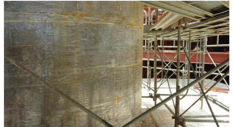
ビニールを巻いた箇所は、巻かない箇所より 透気係数で1ランク上の密実性を実現 （一般） → （良）
