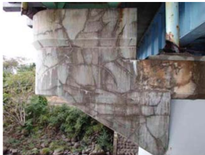
写真 側道橋のASRの事例(1986年(昭和59年)供用)
