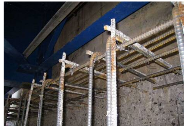
橋台の添え筋による補強
