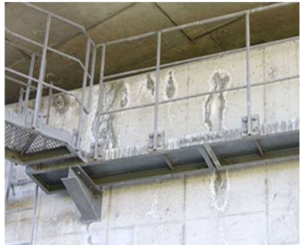
北陸自動車道の橋台(富山県)での実施例
