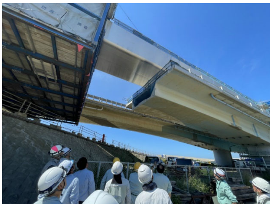
桁下より新旧橋げたの状況
